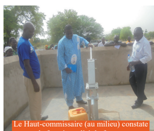
Le Haut-commissaire (au milieu) constate la fonctionnalité du forage
