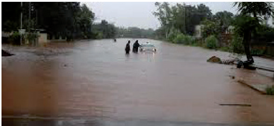
Une route principale complètement inondée
