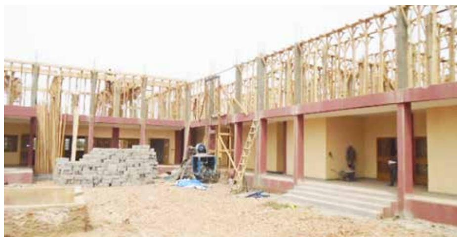
Chantier de l'université de Fada.
